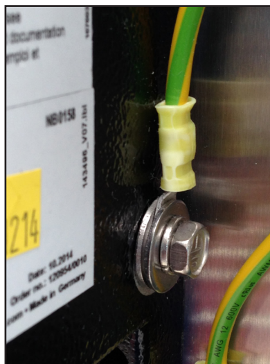
Abbildung 3 Erdanschluss und Kombimutter
